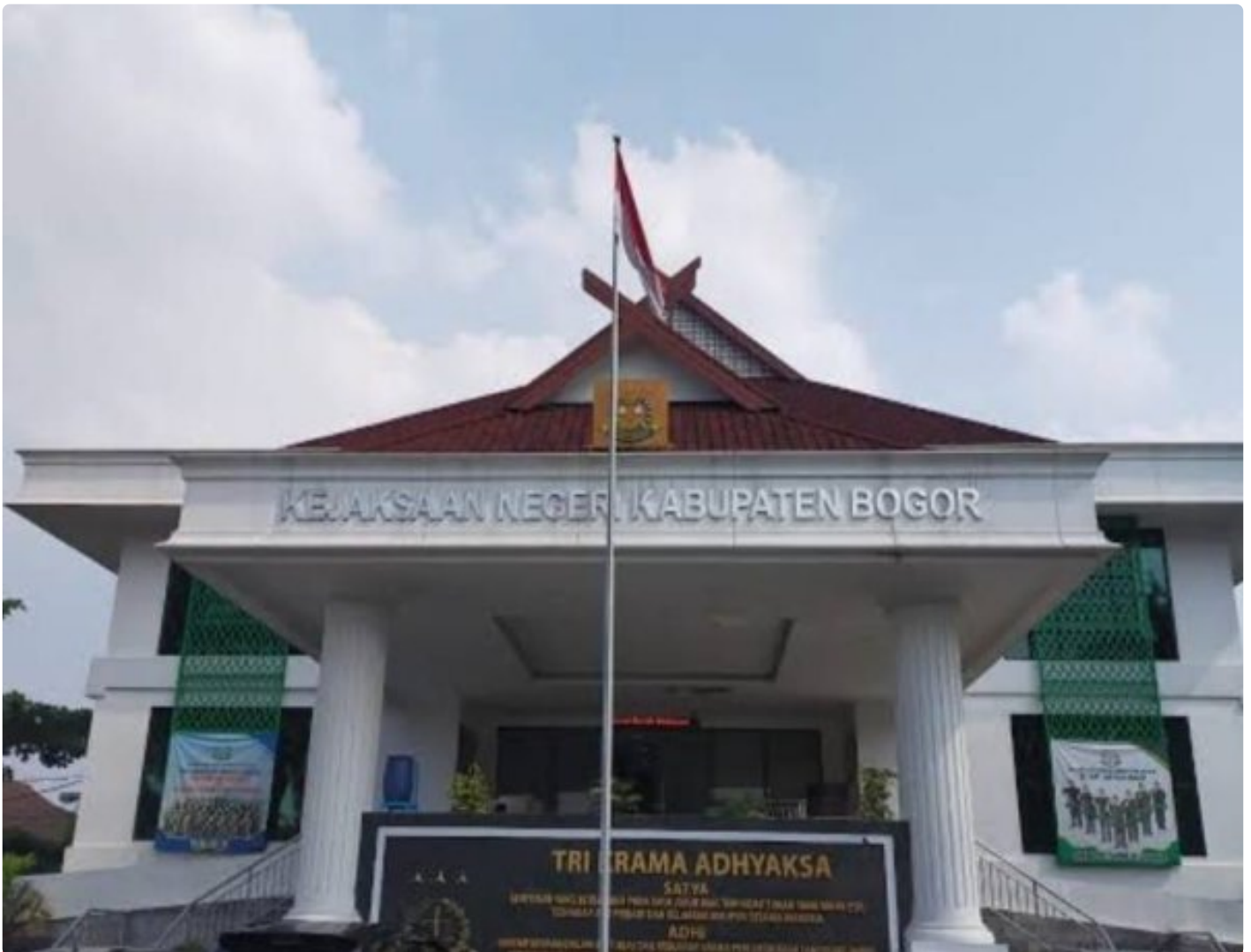
Photo : Gedung Kejari Kabupaten Bogor
